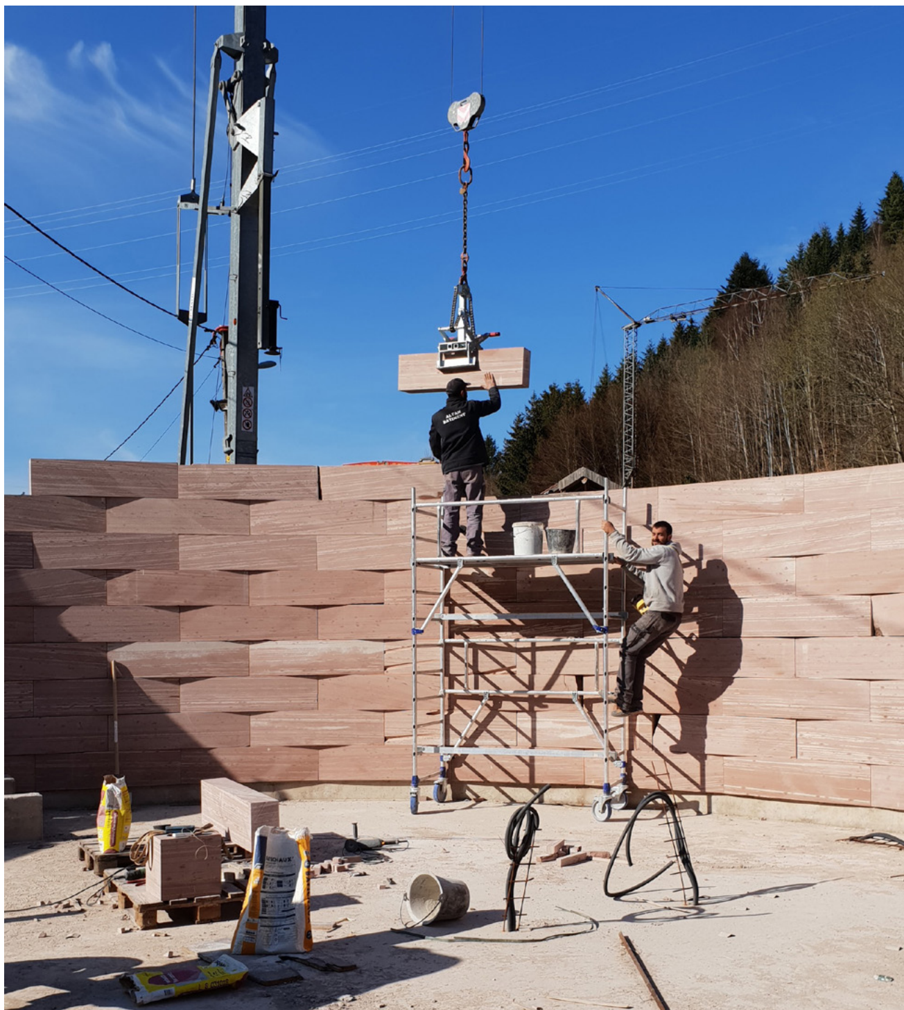
Assemblage du mur périphérique (grès rose des Vosges) de l'office de tourisme de Plainfaing. Studiolada architectes, 2019 ©Christophe Aubertin
